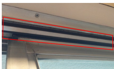
④ サッシの気密材 （黒いゴムの部分）
